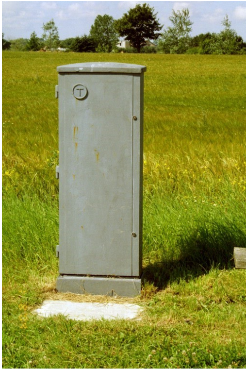
Figur 4.22.4.2 Et telefonfordelerskab. Det er nu placeret i Andelslandsbyen "Nyvang" [OP]
