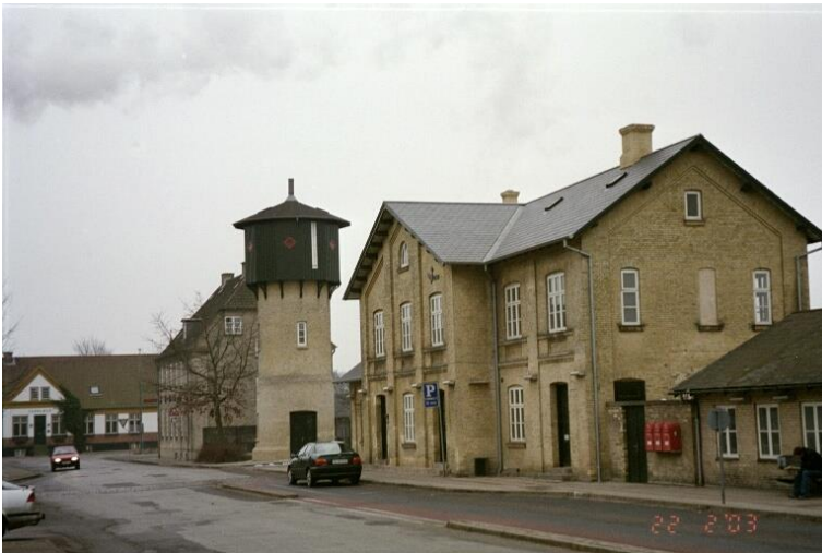
Figur 2.2.7 Skørping med vandtårnet. I baggrunden ses posthuset. [OP]
