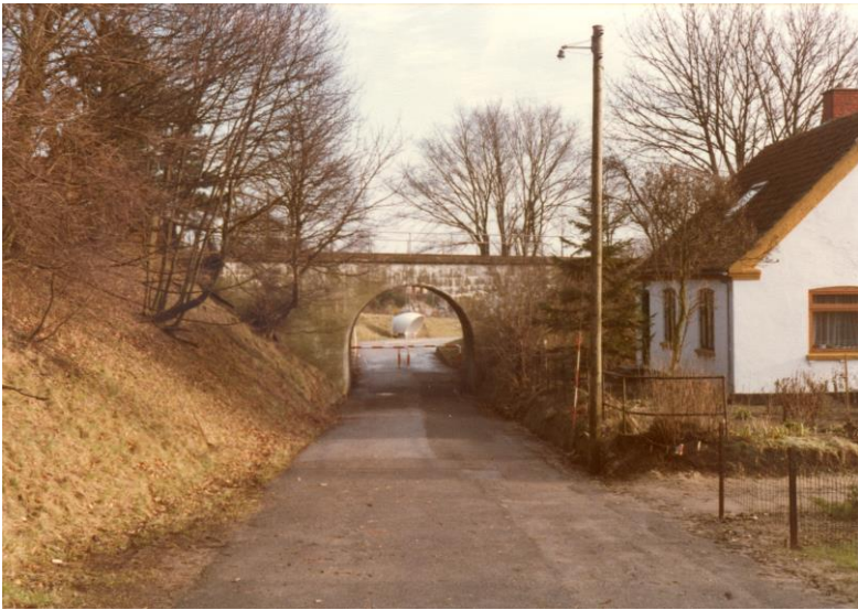
Figur 2.8.3 Slagelse – Vårslev banens / HTJ's overføring over Byvej i Slagelse [OP]
